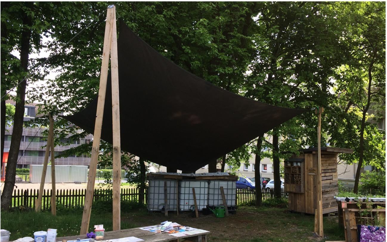
Segelecken rauslaufen, worunter wiederum ein IBC-Container zum Auffangen des Wassers bereitsteht. Das Segel sollte an der höchsten Stelle circa 3 bis 4 Meter hoch gespannt werden.
